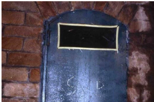
Accès adapté aux chauves-souris dans la porte de la cave du Château de Trévarez (29)
