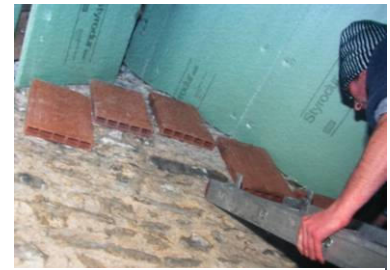
Pose de briques creuses dans une maison forestière
